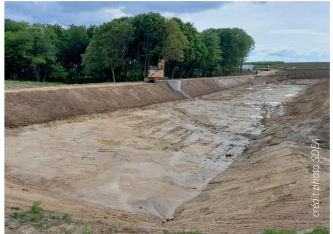
Ouvrage de rétention en déblai et remblai sous forme de digue en terre
