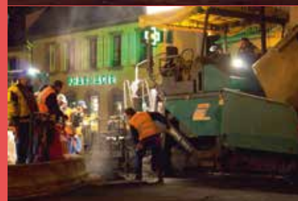
Les travaux de nuit du 10 au 11 octobre, point d'orgue de l'opération
