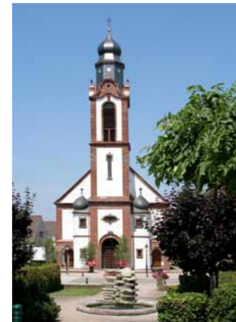
La rénovation de l'église en cours d'achèvement
