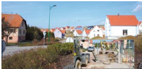
La rue des vignes lors de la reprise des travaux
