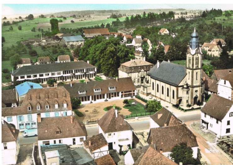
Le groupe scolaire terminé
