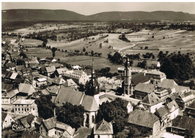
Le groupe scolaire en construction
