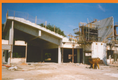
Le gradin de 225 places est construit avant les murs
