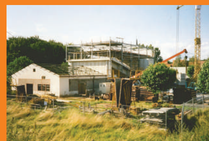
Le bâtiment prend de la hauteur avec l'ajout d'une extension
